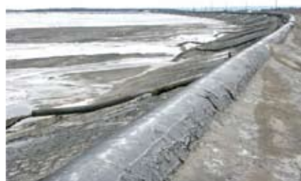
Rys. 2. Namywanie sekcji na OUOW Żelazny Most
