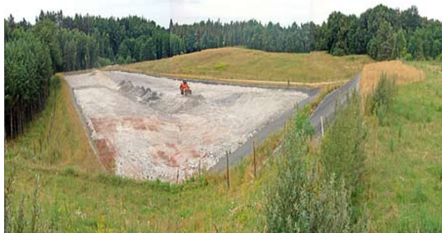
Rys. 7. Obiekt Unieszkodliwiania Odpadów Wydobywczych w Jakubowie w fazie budowy
