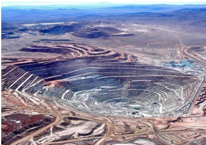
Instalacja rur HOBAS w kopalni Escondida w Chile
